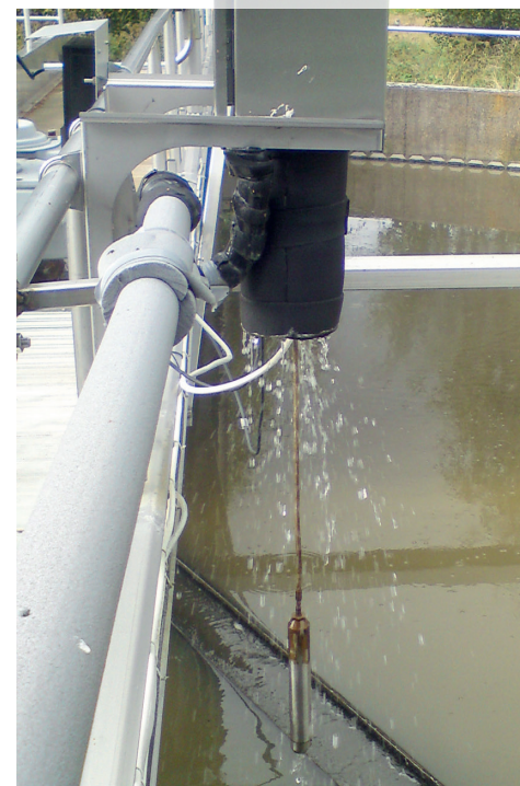
Die CBX ist in einem Schaltschrank aus Edelstahl eingebaut und kann in einer Vielzahl von Umgebungen installiert werden. Es verfügt über eine automatische Spülung des Sensors und des Kabels nach jedem Löten.
