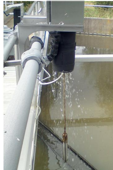
CBX avec ensemble de montage pour une fixation facile main courante. Système de rinçage automatique du câble et capteur après chaque cycle.
