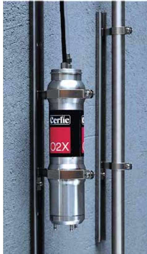
En justerbar skenarmatur gör det möjligt att placera givarna med hög precision mot vattennivån eller annan nollpunkt. Det är lätt att montera eller demontera givarna vid inspektion, rengöring eller kalibrering.
