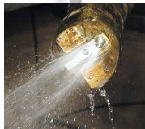
Den automatiska renspolningen innebär litet underhåll. Givarna sköter sig själva. De har inbyggd rengöringsautomatik som fungerar med vatten eller tryckluft.
